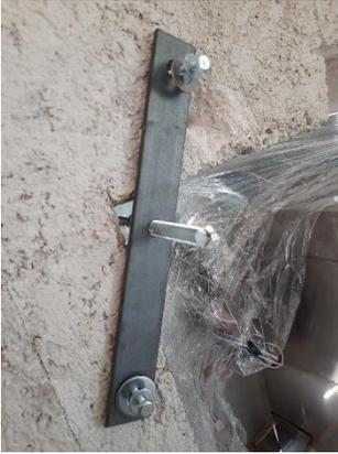
Una vez fijadas todas las soleras a las esquinas, fijar la varilla estriada a las soleras con las tuercas y rondanas proporcionadas como se ve en la imagen.
