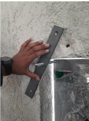
Fije los tornillos junto con las rondanas, a la altura marcada previamente
